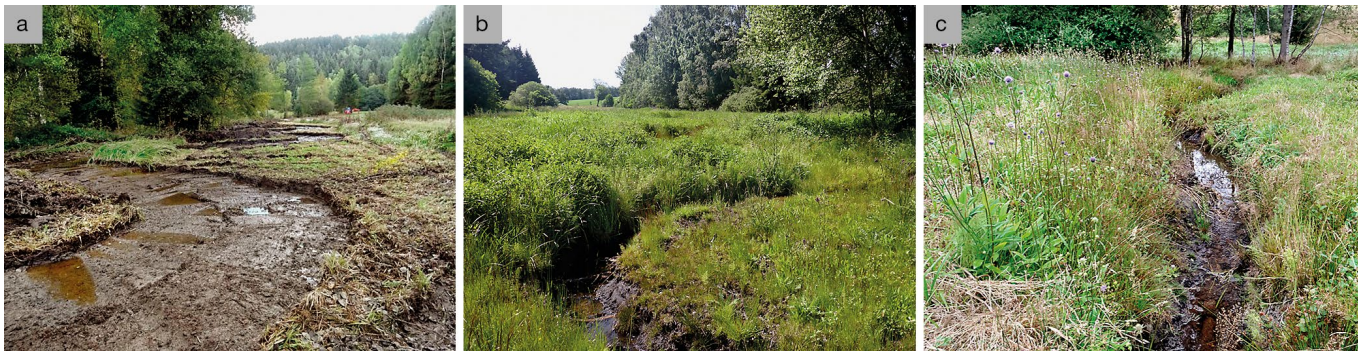
Abb. 3: Mäander und abgetragener Oberboden dienen dem Wasserrückhalt sowie der Entwicklung einer der Flussperlmuschel ( Margaritifera margaritifera ) zuträglichen, krautreichen Vegetation: a) während der Renaturierungsmaßnahme, b) im ersten Jahr nach dem Eingriff im Frühjahr, c) im zweiten Jahr nach dem Eingriff im Sommer. (Fotos: a, c: Thomas Findeis, b: Franziska Jecke)
