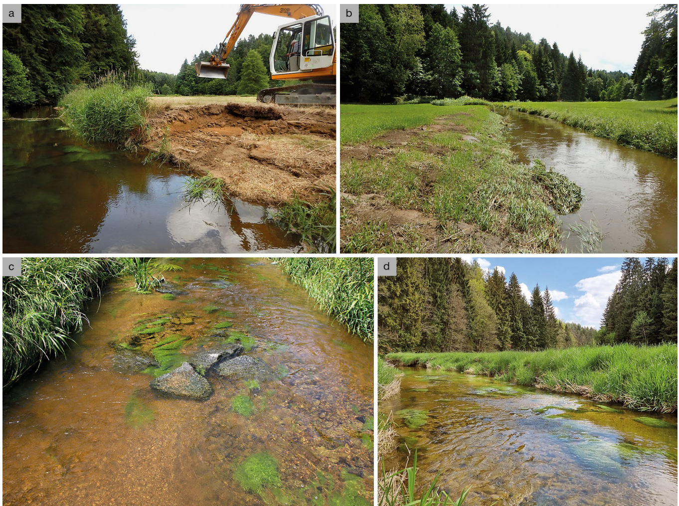
Abb. 2: Beispielhafte Maßnahmenumsetzung zur Strukturverbesserung von Fließgewässern: In einem monotonen, versandeten Abschnitt mit starken Uferabbrüchen wurde durch Uferabflachung (a, b) zunächst die Vernetzung mit der Aue verbessert. Anschließend wurde durch Einbau von Strukturelementen (hier: Störsteine und Grobgeschiebe) ein abwechslungsreich strukturierter Gewässerabschnitt mit vielfältigem Substrat und unterschiedlichen Strömungsverhältnissen geschaffen (c, d), der für Muscheln und andere Organismen geeignete Mikrohabitate bietet. (Fotos: a, b, c: Marco Denic, d: Franziska Jecke)
