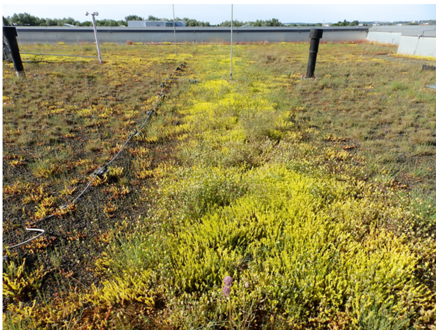
Abb. 2: Dach mit 10 cm Substrattiefe und zwei verschiedenen Substraten: im Vordergrund bis Bildmitte Ulopor, im Hintergrund Optigrün. Der Streifen mit der Düngergabe verläuft über beide Substrate. Aufnahme im Juni 2021 (Foto: M. Köhler).
