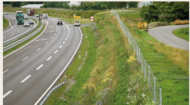
Abb. K2-2: Mindestanforderung an die Funktionsfähigkeit von Begleitgrün ist die Festsetzung geeigneter Pflegeregime, z. B. im landschaftspflegerischen Begleitplan (LBP). Artenreiches Begleitgrün auf Magersubstraten, das nicht großflächig einheitlich gepflegt wird, kann erheblich zur Lebensraumvernetzung beitragen. Abschnittsweise zeitlich versetzte Mahd oder Streifenmahd (Foto: Bundesstraße B 30n, im Jahr 2020) verhindert das Erlöschen von Kleintierpopulationen. (Foto: Heinrich Reck )
