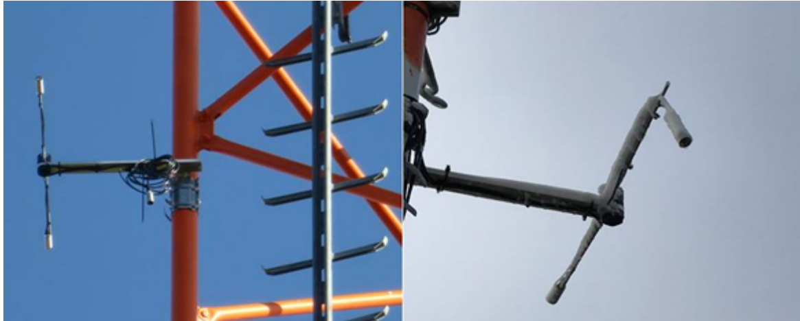
Abb. 62: An einem Ausleger montierte Mikrofone der zwei BATmode S+-Systeme. Links direkt nach der Montage, rechts bei einer Kontrolle am 27.11.2019 mit Vereisung und herabhängendem Mikrofon
