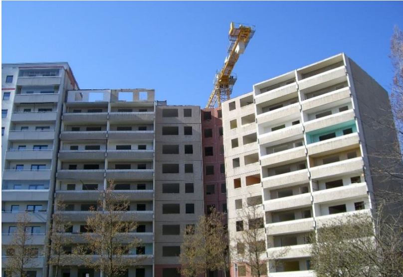
Abbildung 29: Abbrucharbeiten im Schorfheideviertel Berlin (Foto: gruppe F – Landschaftsarchitekten)
