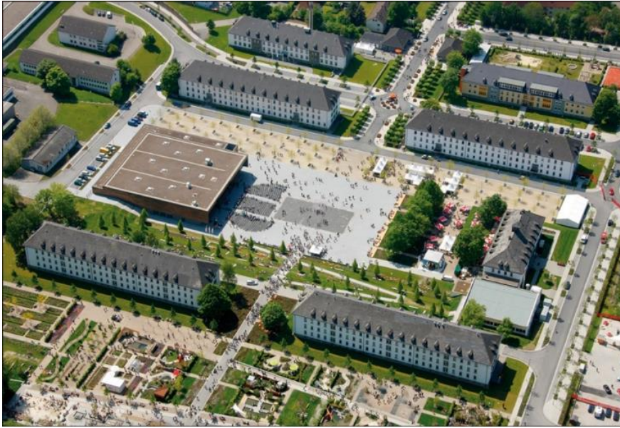
Abbildung 26: Luftbild des Kasernengeländes in Hemer (Foto: Sauerlandpark Hemer GmbH)
