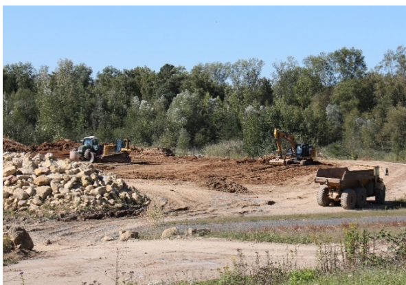
Abb. 254: Materiallager für die Sanierung der Altdeponie Monte Scherbelino – ein Jahr vor Projektbeginn (Foto: Th. Hartmanshenn, Sept. 2015)...
