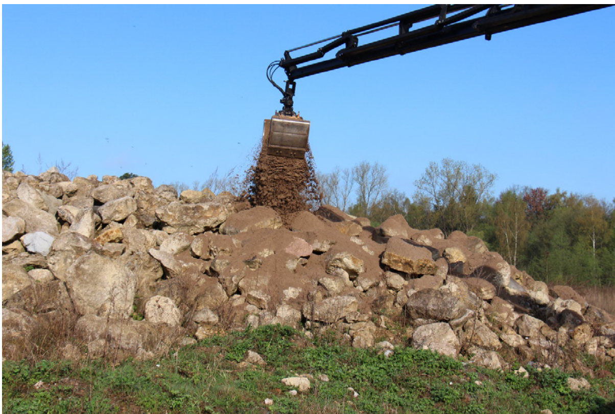
Abb. 1: Verfüllung eines aus der Zeit der Sanierung der Deponie verbliebenen Geröllhaufens am Monte Scherbelino in Frankfurt am Main mit Sand – Schaffung von Lebensräumen für v. a. Wildbienen und Reptilien (Foto: Th. Hartmanshenn, April 2018)
