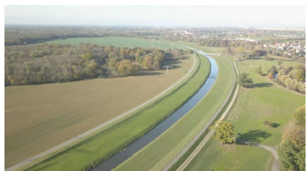
Die neue Luppe in den Elster-Luppe-Auen nördlich von Leipzig wird von flussnahen Deichen begleitet.
