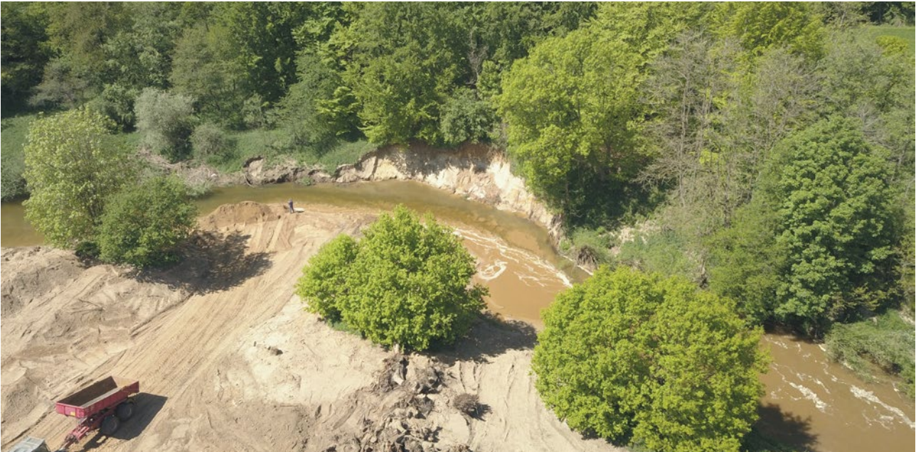
Umsetzung von Baumaßnahmen zur Renaturierung der Ems im Bereich „Truppenübungsplatz Dorbaum“
