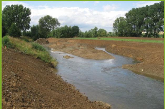
🌊 Kartenausschnitt: Auenzustand (links unten). Neugestalteter Laufabschnitt der Nidda unmittelbar nach der Baumaßnahme (rechts unten), im Hintergrund ist der zurückverlegte Deich zu sehen.
