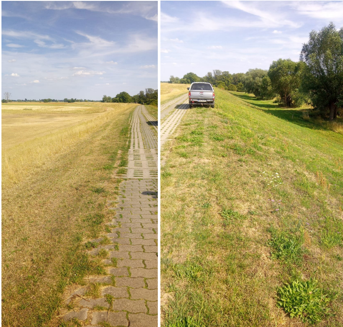
Abb. 84: Rechts und links des Deichkronenweges wird die Berme mit einem fünf Meter Puffer beweidet (Bilder: Swen Keller).
