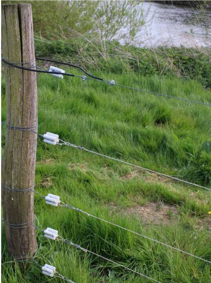
Abb. 7: Semipermanentes wolfsabweisendes Zaunsystem mit Porzellan-Zugisolatoren an fest in den Boden gerammten Robinienholzpfählen und einer Kombination aus aufwickelbaren Kunststofflitzen sowie fest gespanntem Glattdraht (Bild: Peter Schütte).
