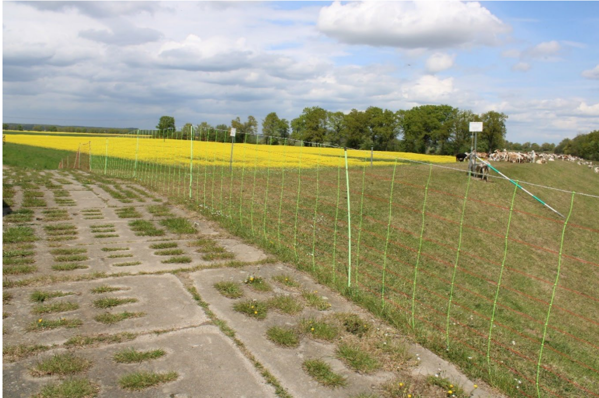
Abb. 33: 105er Elektronetze mit starren Senkrechten und Doppelspitze auf dem Deichkörper. Die Wege entlang der beweideten Fläche müssen stets passierbar sein, Warnschilder müssen aufgestellt werden (Bild: Peter Schütte).
