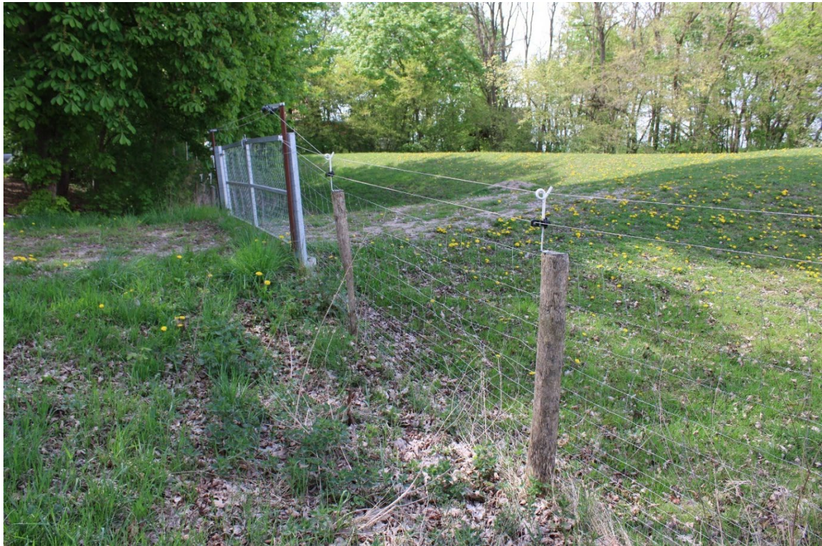
Abb. 36: Eingegrabener wolfsabweisender Knotengeflechtzaun, welcher mit zwei zusätzlichen Litzen als Überkletterschutz aufgerüstet wurde (Bild: Peter Schütte).
