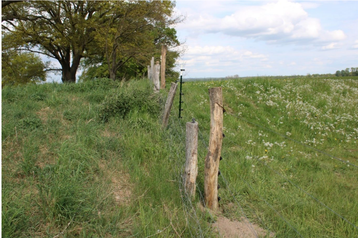
Abb. 38: Neubau eines sechsreihigen wolfsabweisenden Elektrofestzaunes hinter einem alten Knotengeflechtzaun (Bild: Peter Schütte).
