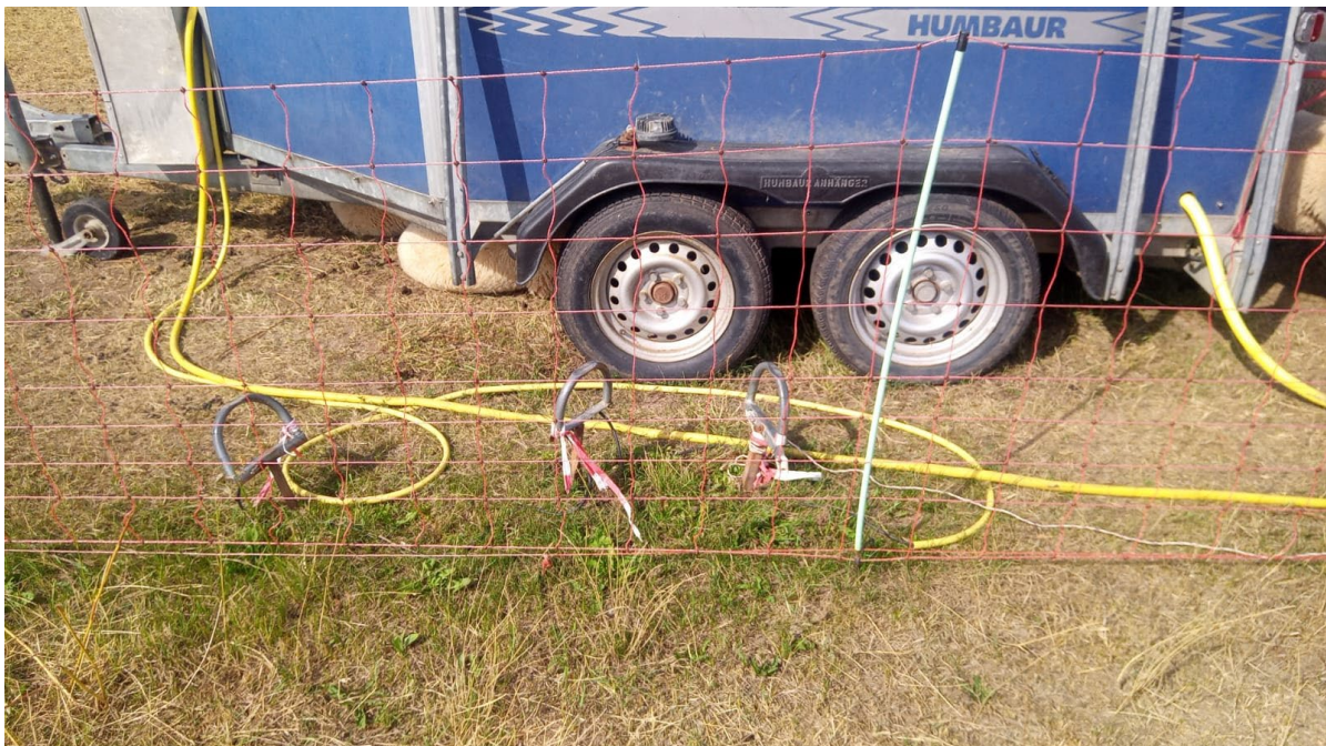
Abb. 86: Die Erdung erfolgt mit drei Erdstäben, die in Reihe gesetzt und verbunden werden. Sie ermöglichen eine Netzspannung von 10.000 Volt (Bild: Swen Keller).
