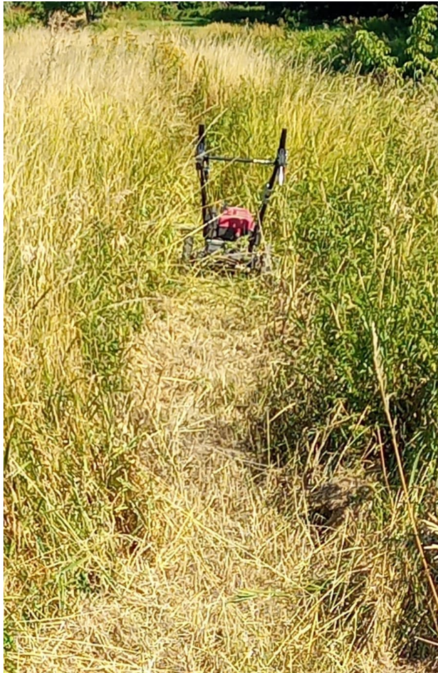
Abb. 81: Das Freimähen der Trasse erfolgt mit einem Hochgrasmäher (Bild: Swen Keller).
