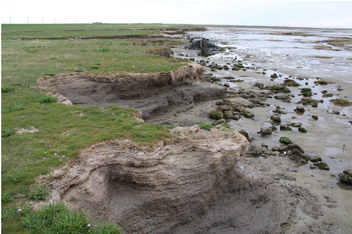
Abb. 18: Abbruchkante am Übergang vom Wattenmeer zu den Salzwiesen im Vorland der Deiche (Bild: Peter Schütte).
