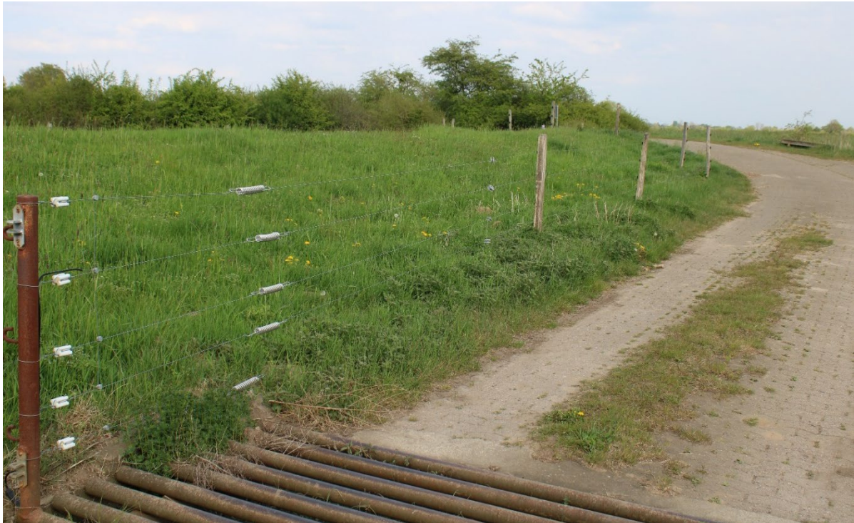
Abb. 4: Wolfsabweisender Elektrofestzaun mit Glattdraht, Porzellan-Zugisolatoren, Temperaturausgleichsfedern und rotierenden Spannern am Deich sowie Zufahrt der Weidefläche mit Viehgitter (Cattle Grid). Das mit Elektrosets gesicherte Weidetor ist hier nicht sichtbar (Bild: Peter Schütte)
