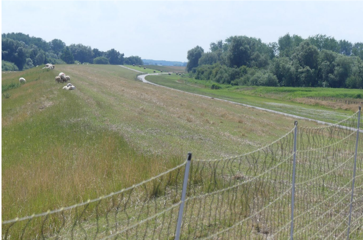
Abb. 55: Die gehölzfreien Deichflächen sind weitestgehend überschaubar, nur an querenden Gräben sind die Flächen unübersichtlich (Bild: Frank Lamprecht).
