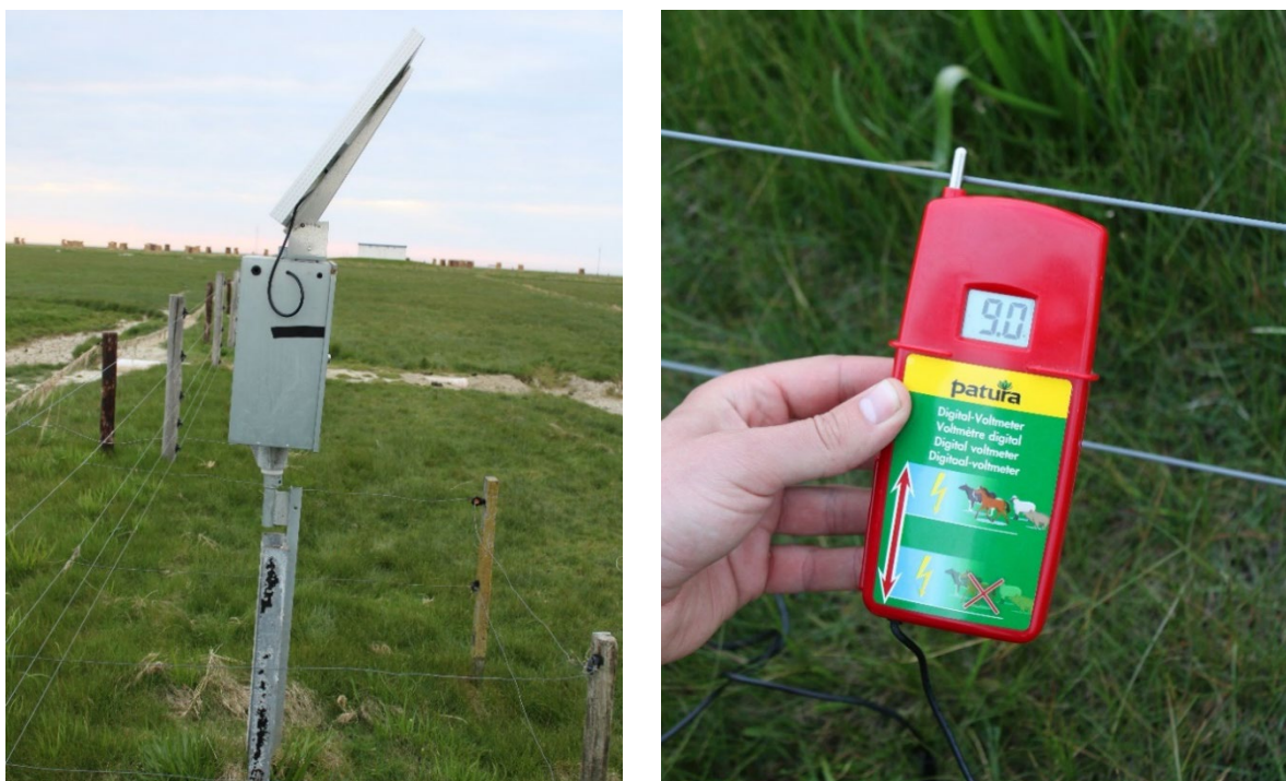
Abb. 23: Elektrifizierung der Zäunung mittels stabilen T-Pfosten, Weidezaungerät, Batterie und Solarpanel (Bilder: Peter Schütte).
