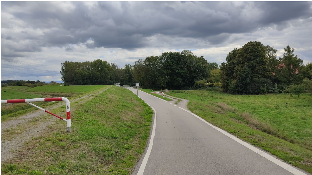
Abb. 106: Die Deiche entlang des Rheins entsprechen bereits den aktuellen Standards. Statt einer Asphaltdecke wird der Verteidigungsweg jedoch mit einer wassergebundenen Wegedecke versehen und der Deichkronenweg ein Grasweg (Bild: Lea Streit).
