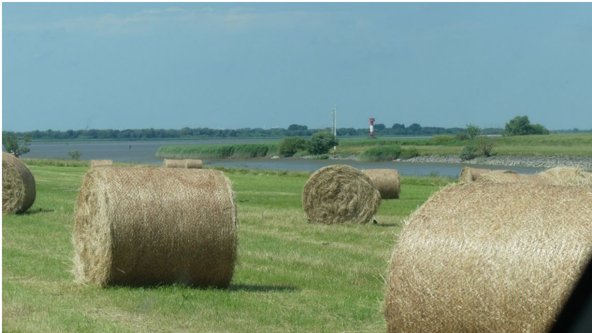
Abb. 54: Mündungsbereich des Krückau-Sperrwerks bei Elmshorn (Bild: Frank Lamprecht).
