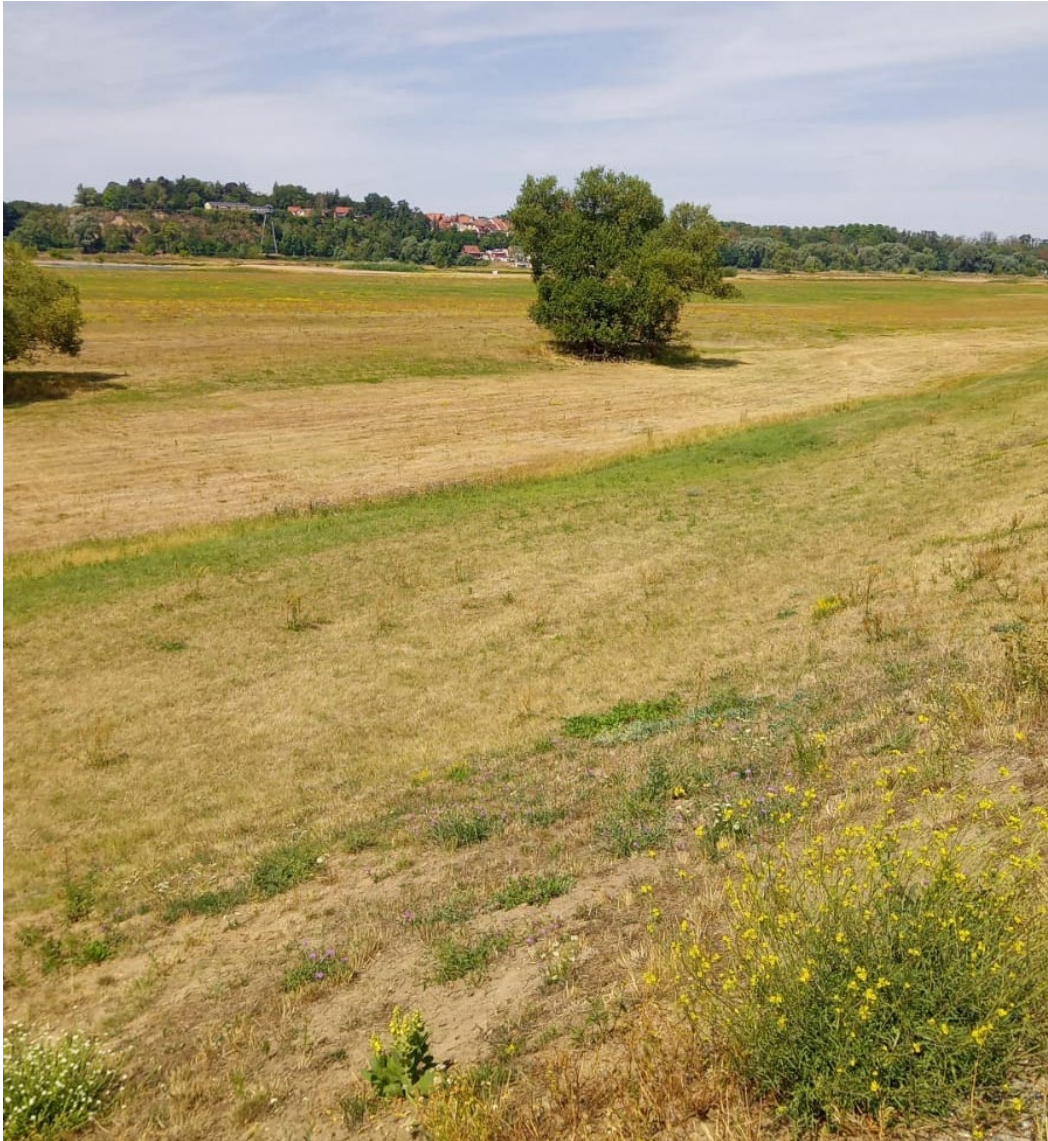
Abb. 94: Gehölze sind auf dem Deichkörper selbst nicht vorhanden, nur im Hinterland (Bild: Swen Keller).
