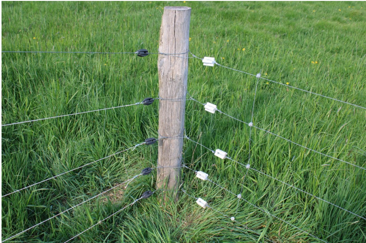
Abb. 8: Semimobiler wolfsabweisender Zaun mit Kunststoff-Zugisolatoren, vier Kunststofflitzten und einem Glattdraht (nach links zulaufend) sowie wolfsabweisend Zäunung mit Porzellan-Zugisolatoren, fünf Glattdrähten und senkrechter Verbindung (nach rechts zulaufend; Bild: Peter Schütte).
