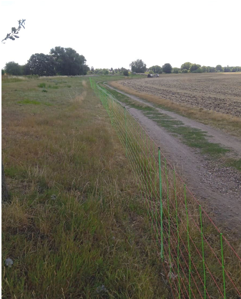
Abb. 80: Parallel verlaufender Weg entlang der Zauntrasse. Übersprungmöglichkeiten für den Wolf sind entlang den Zaunrassen nicht vorhanden. Zum Einsatz kommen Netze mit 106 cm Höhe und starren Senkrechten (Bild: Swen Keller).
