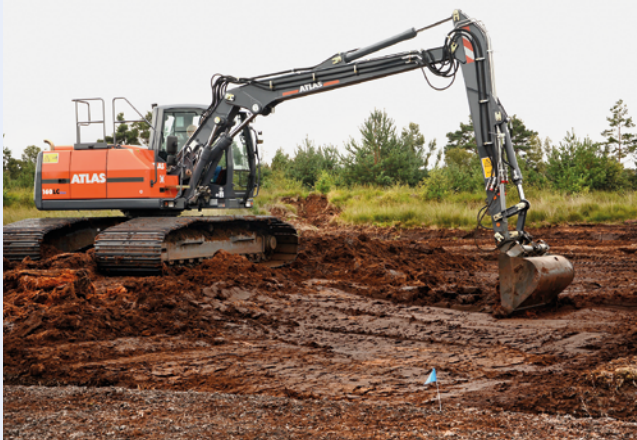
Abb. K1-1: Bagger bei der Oberflächenmodellierung. (Foto: Lotta Zoch)
