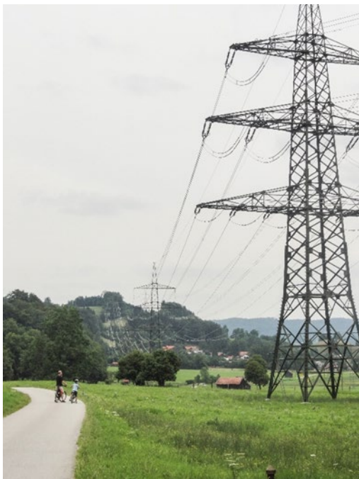
Abbildung 78: Wirkfaktor „Rauminanspruchnahme oberirdisch (Mast)“. (Foto: Weingarten).
