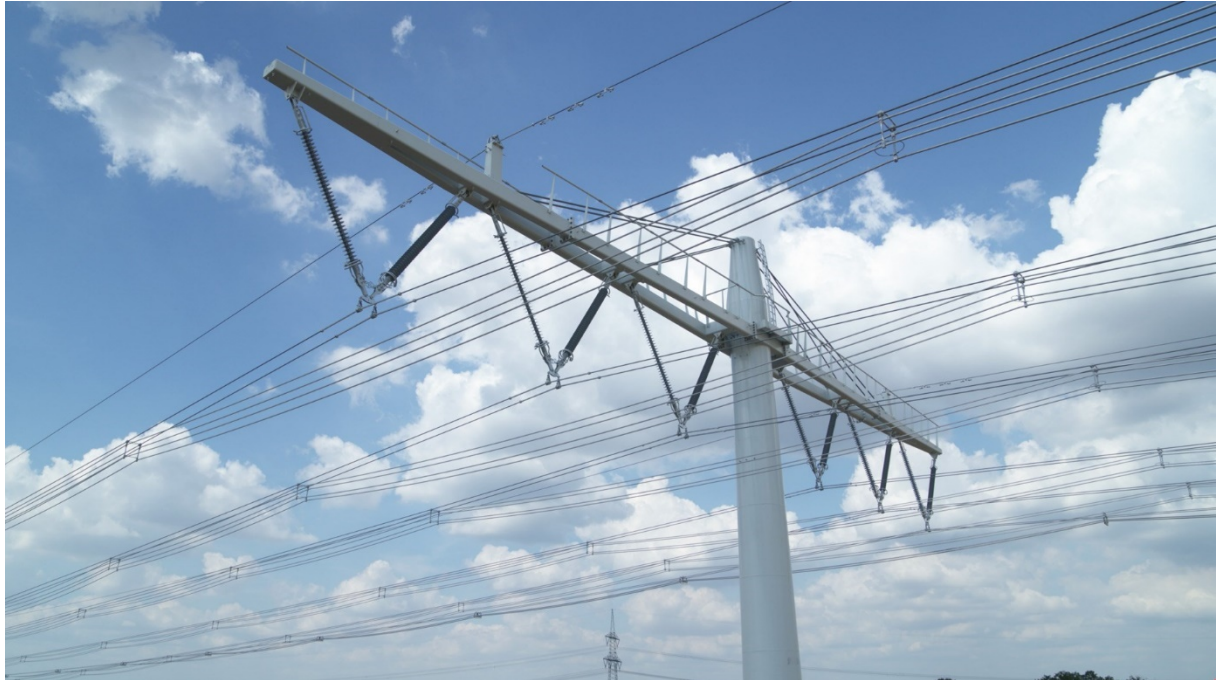
Abbildung 29: Einebenen-Anordnung der Leiterseilbündel mit zwei Tragseilen (50Hertz 2019).
